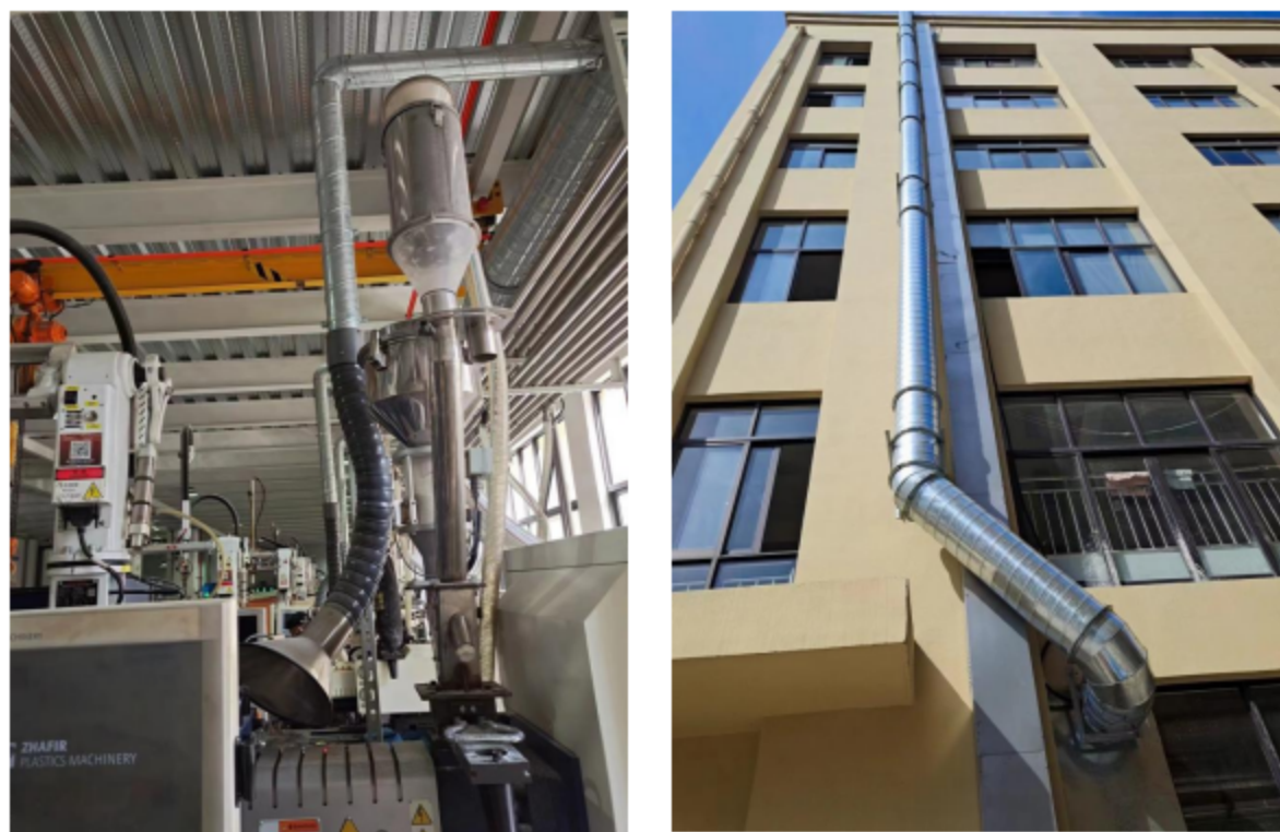
注塑车间集气照片及排气筒
